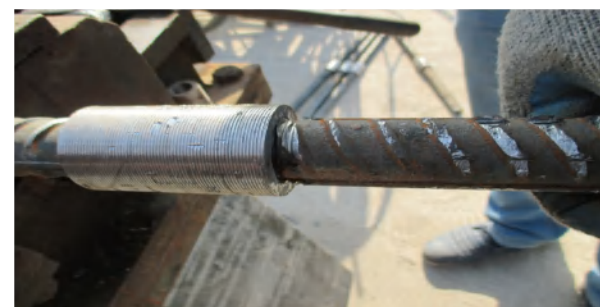
(7)、接头拧紧后丝扣允许外露 1~2 扣，实际外露 1.5 扣
