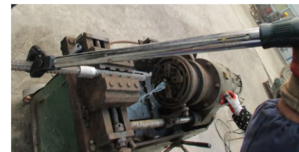
(6)、按照 JGJ107-2013 中 6.2.1 中直螺纹接头安装时最小拧紧扭矩时值 \Phi 28:320(N \cdot m) 实际扭矩值为 :330( N \cdot m )
