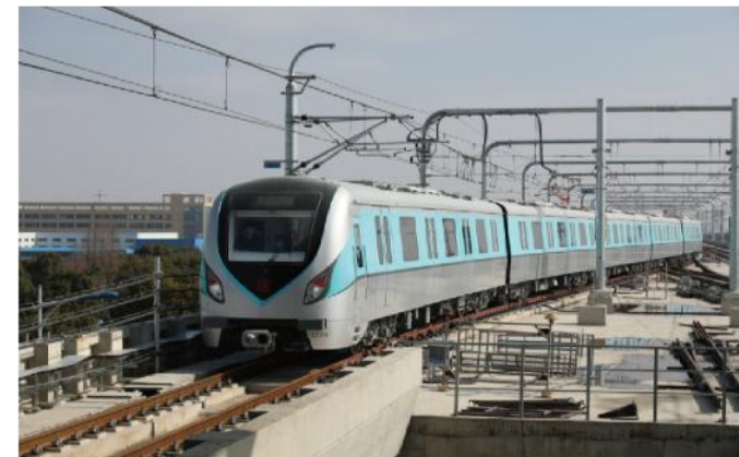
常州地铁2号线2标 Changzhou Metro Line 2 Project
