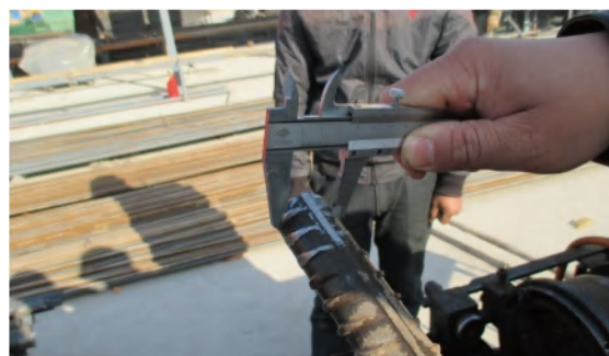
(2)、按接头的外形尺寸加工 \Phi 28 钢筋剥肋直径为 26.6，实际剥肋直径约为 27.5
